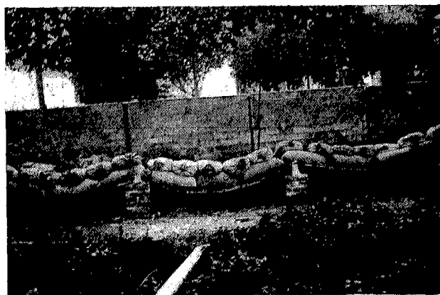
Fig. 22.—Rotura de un forjado ligero, para cubiertas, sometido a una sobrecarga de 500 \text{ Kg./m.}^2 .
