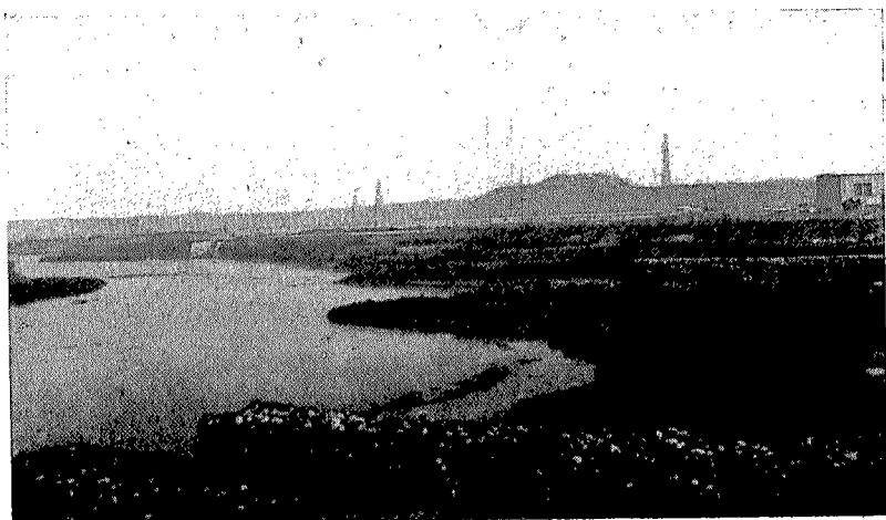
Espigones de defensa de la estación. Se aprecia la ya abundante sedimentación producida.
