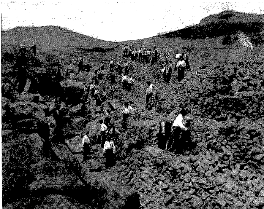
Canteras de basalto, en Ciudad Real, abastecedoras de adoquines para la pavimentación de Madrid en los años 1915 y siguientes.
