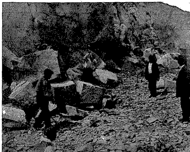
Extracción de bloques y preparación de adoquines de granito porfídico en un frente de cantera.
