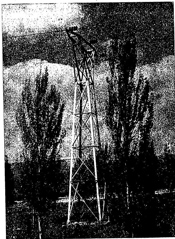
Vista general de uno de los postes.
