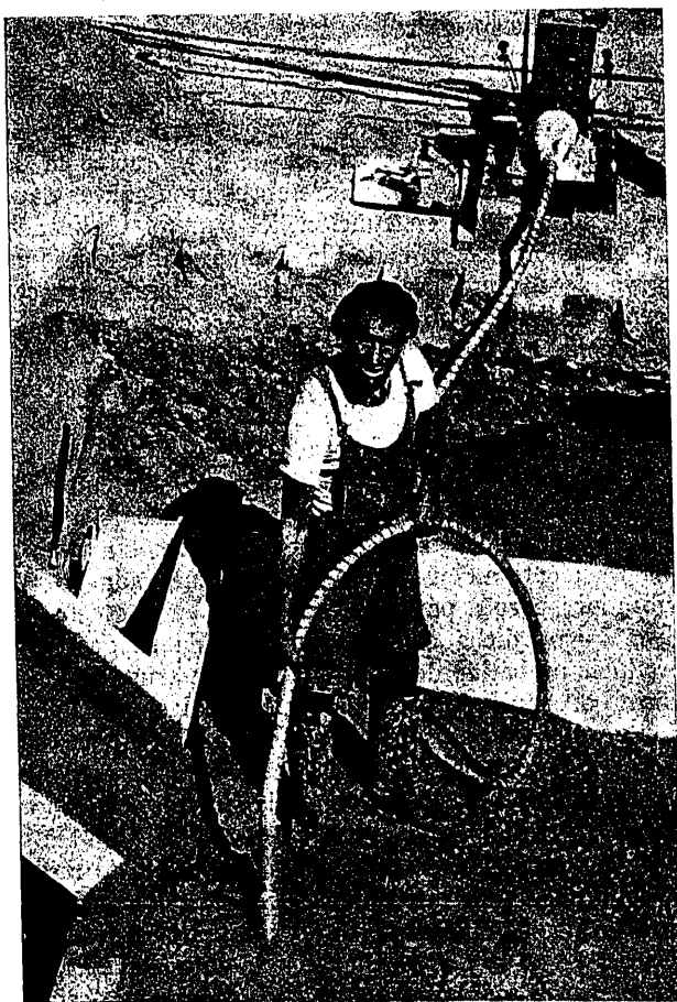
Pervibrador en acción, en la ejecución de un macizo de cimentación de hormigón en masa.
