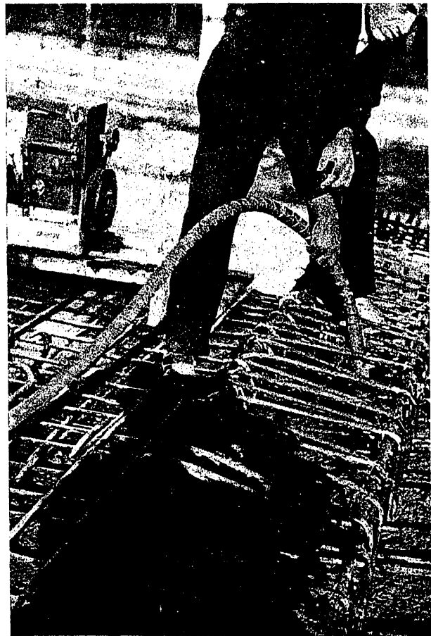
Pervibración del hormigón en una viga fuertemente armada.
