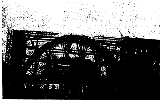
Cimbra de los arcos laterales.
