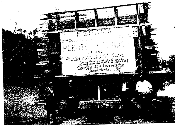
Fot. 6.ª — Pruebas del pilotaje. Hundimiento, 3/10 de mm.
