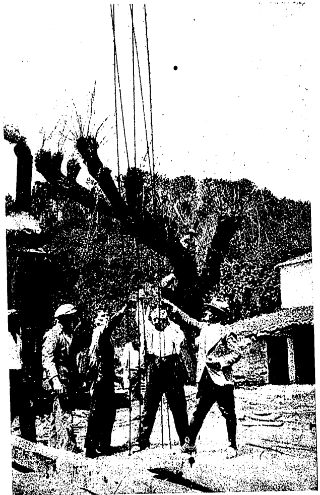
Fot. 3.ª — Martinete para el pilotaje.
