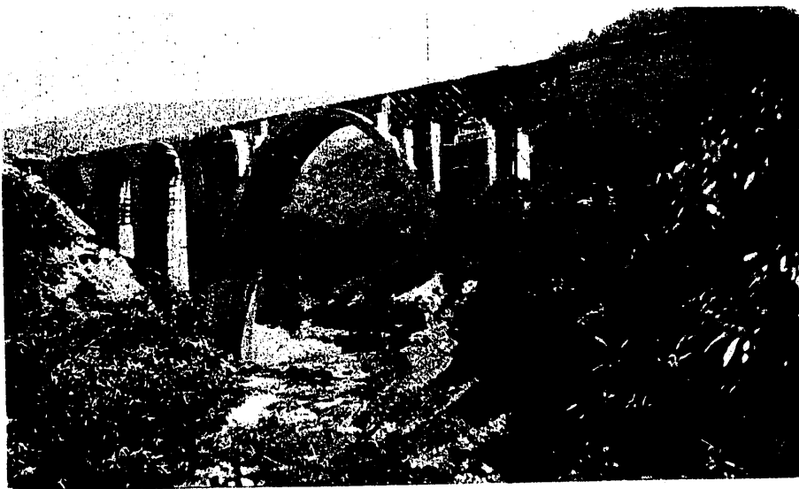
Fig. 10. Puente del Lor, en la línea de Galicia. Sustitución de tramos metálicos para vía única por un puente de hormigón armado para vía doble.
