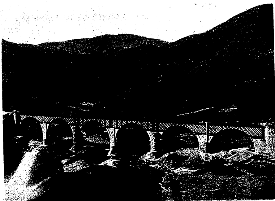
Fig. 8. a — Sustitución del puente metálico de Penadola, en la línea de Galicia, por arcos de hormigón armado.
