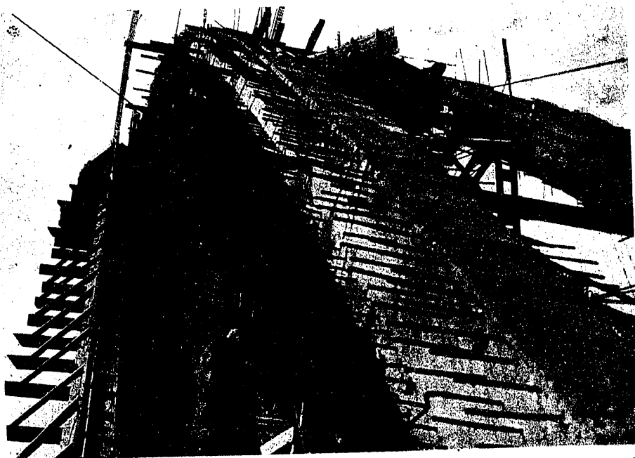
Rosca núm. 1, hormigonada, con los hierros de espera para solaparlos con los de las otras roscas.
