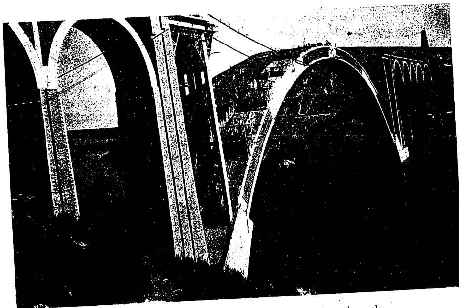
Viaducto del Esla. Vista general del arco hornigonado.
