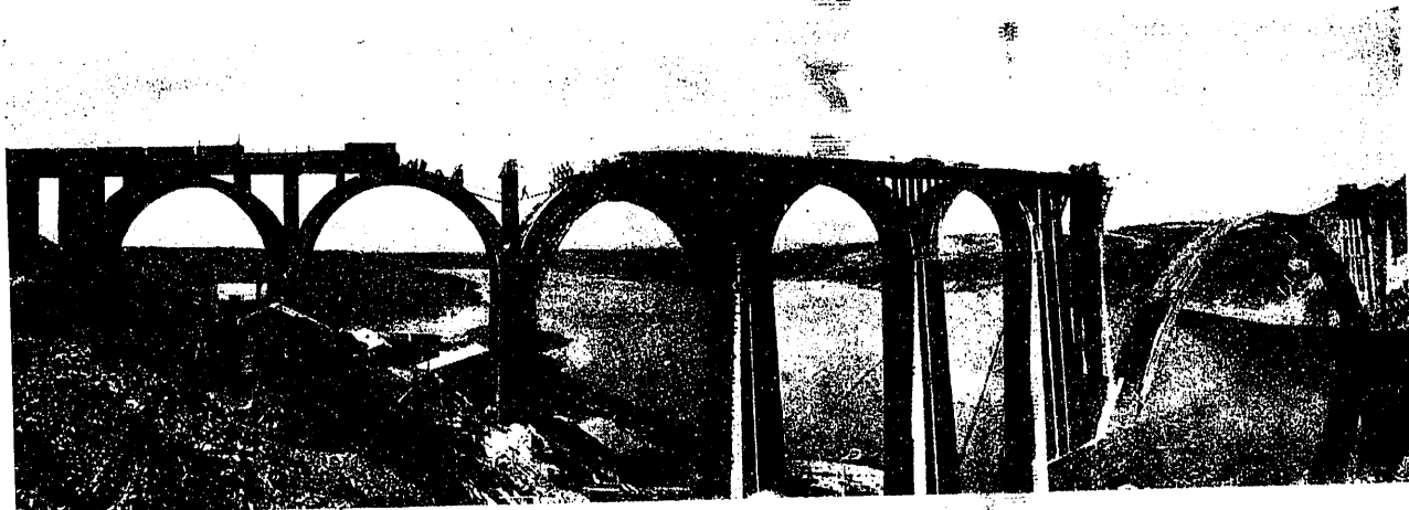
Construcción de arcos y tímpanos de los viaductos de acceso y cimbra del arco principal.
