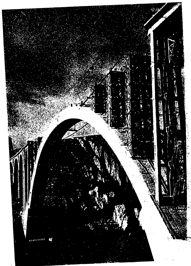
Construcción de los tímpanos.
