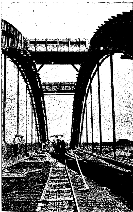
Un tramo en la fase de hormigonado.
