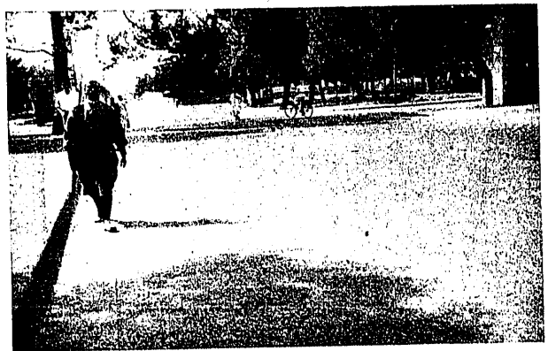
El más moderno bulevar de Tánger: 25 metros de ancho. Pavimento de macadam con emulsión asfáltica.
