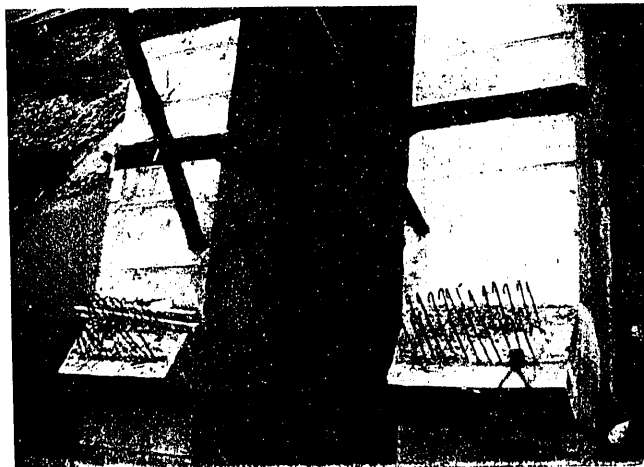
Fot. 13. — Detalle de una junta.
