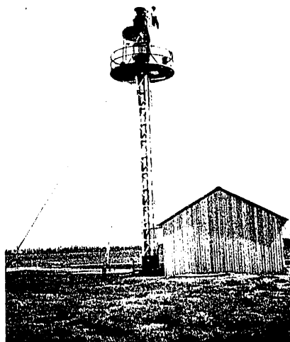
Poste de amarre, de 16,50 m. de altura.
