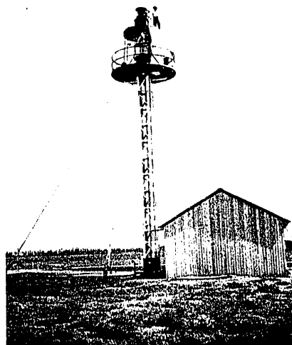
Poste de amarre, de 16,50 m. de altura.
