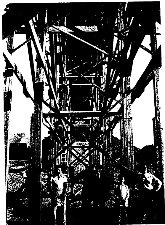
Fot. 8.ª — Montantes y arriostramientos de la cimbra.
