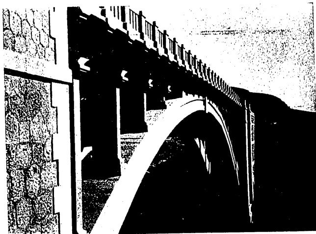
Fot. 2.ª — Otra vista del puente.
