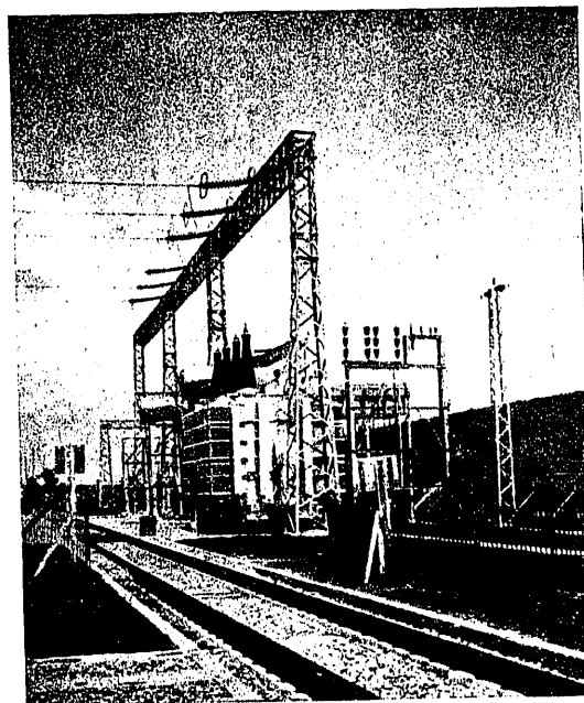
Transformador de 40 000 k. V. A. a 220 k. V.
