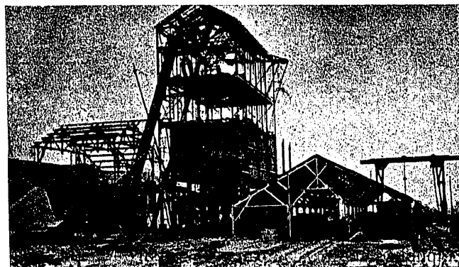
Estación central de machaqueo durante su montaje.
