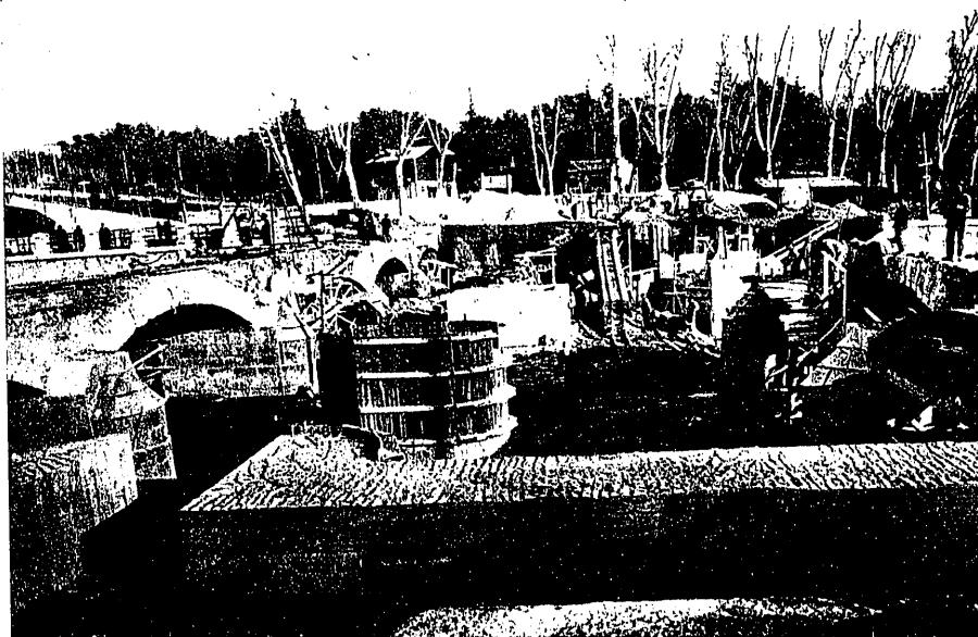
Fig. 1.ª — Construcción de pilas y bóvedas. A la izquierda, el frente de aguas abajo del puente antiguo, sin las boquillas de los arcos. Los sillares de las pilas están numerados para levantarlos y trasladarlos a su nuevo emplazamiento. En el centro, cuatro apoyos intermedios, el primero, unido al muro de encauzamiento; el segundo, con el encofrado para la superestructura; el tercero, hincado el cajón, y el cuarto, preparado el cajón para la hínca. A la derecha, construcción del nuevo frente de aguas abajo con los sillares del antiguo.
