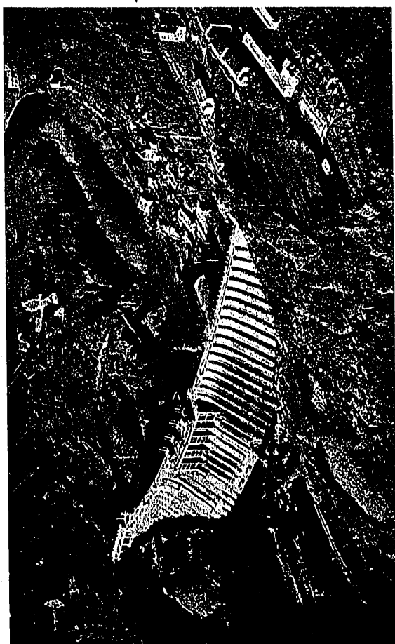
Fig. 5. a — Presa de Vézins, vista desde aguas arriba.
