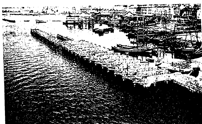
Fig. 13. — Muelle de hormigón armado, número 3, en construcción.
