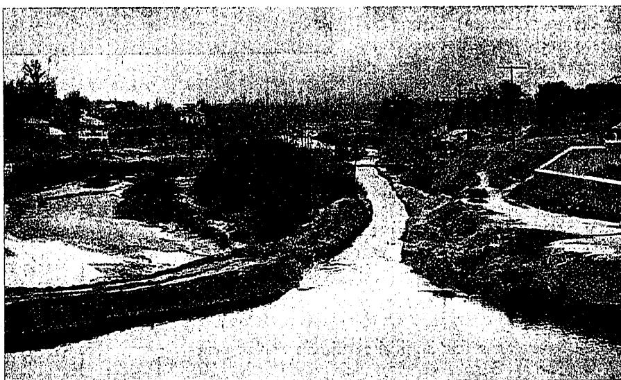
Fig 9. Atagüa y cauce de desviación
