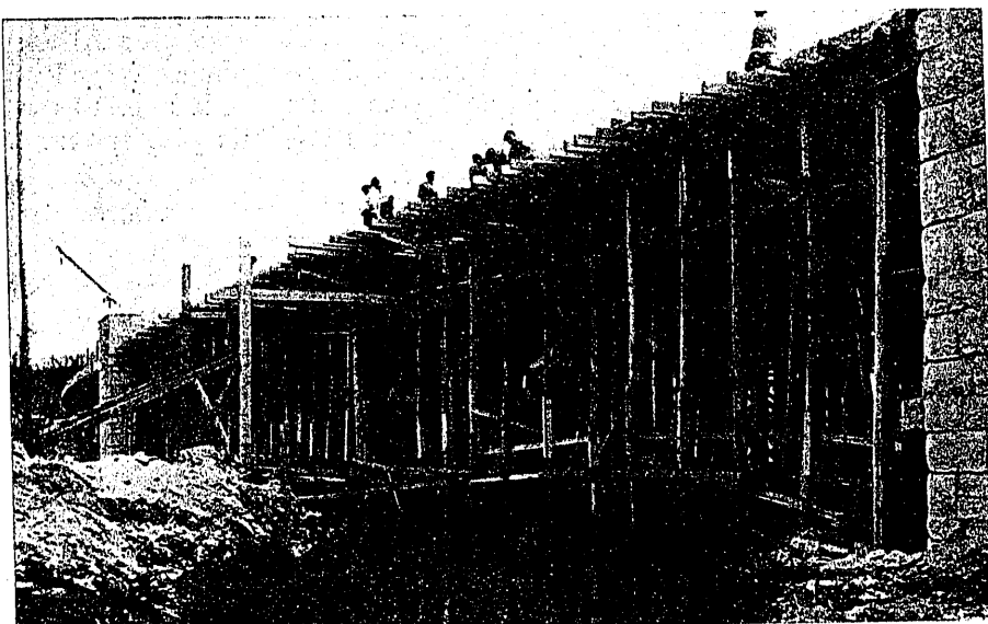
Fig. 7. Disposición de la cimbra
