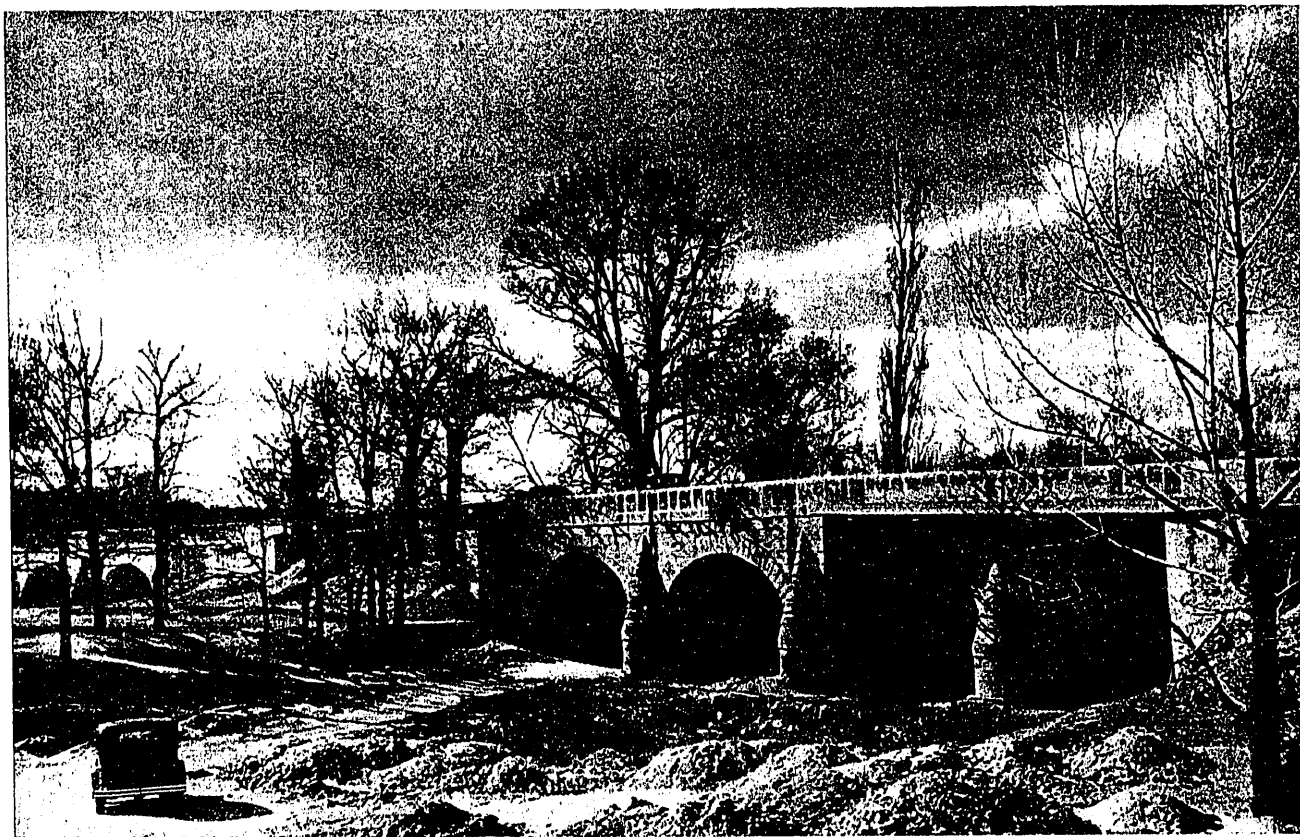
Fig. 1. Vista general del antiguo puente de San Fernando, cuya conservación ha sido una de las determinantes del desvío construido
