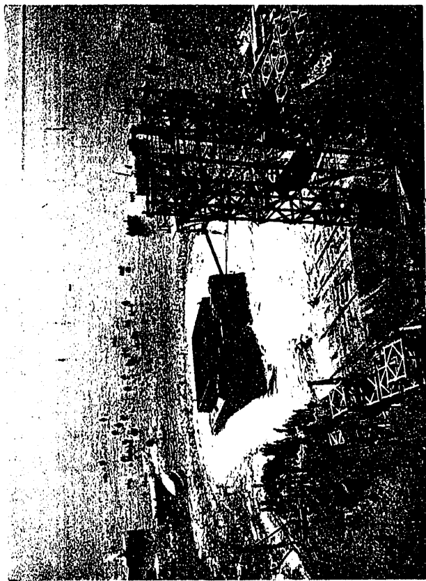
Fig. 9. Botadura de un cajón
