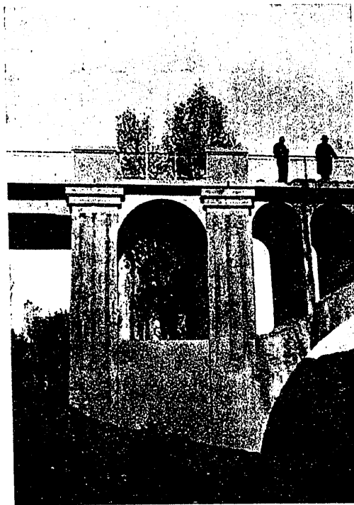
Foto. 5. Aligeramientos de los estribos
