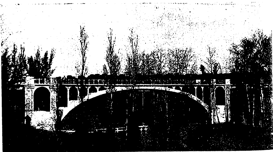
Foto. 6. El puente, terminado
