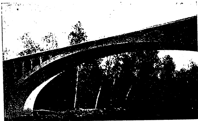
Foto. 4. El arco después del descimbramiento
