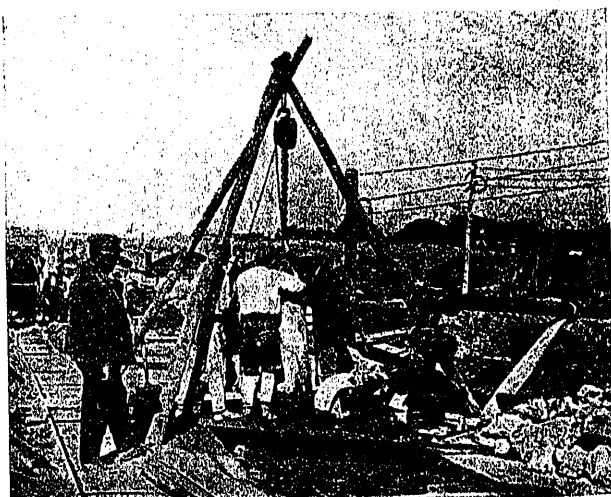
Fig. 5. Colocación del tubo para sumergir hormigón en un cajón de la segunda pila (19-XII-29)
