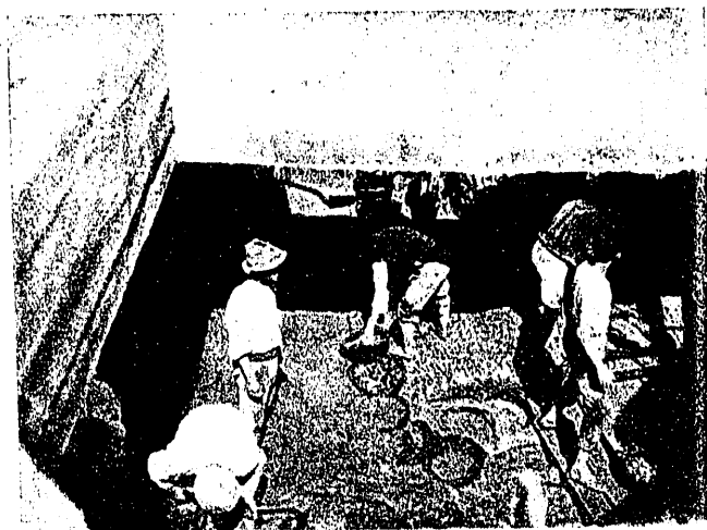
Fig. 3. Excavación en un cajón del estribo derecho
