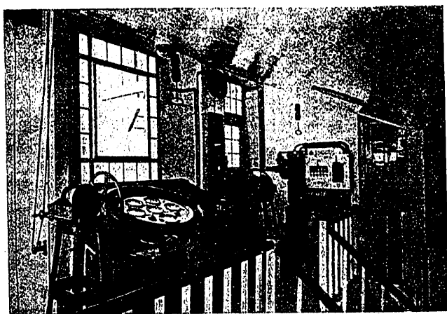
Foto E. Central de mando del funicular de Zugspitz. Instalación eléctrica Siemens-Schuckert
