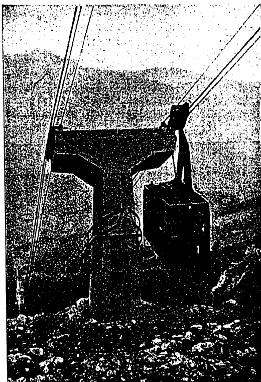
Foto R. Castillete de hormigón armado en el funicular de Kreuzeck
