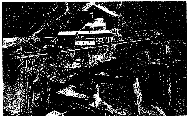
Fig. 1. Puente de servicio e instalación para el hormigonado de la presa
