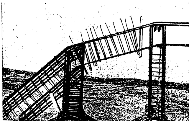
Fig. 6. Detalle de las armaduras de un nudo y de los montantes
