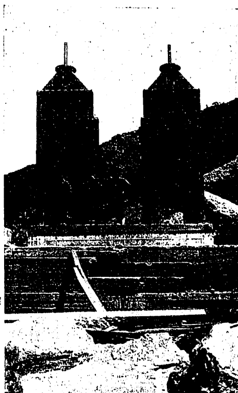
Fig. 5. Compuertas y cámaras de alojamiento. Frente de aguas abajo
