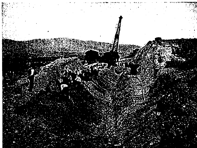
Trabajo de la máquina excavadora
