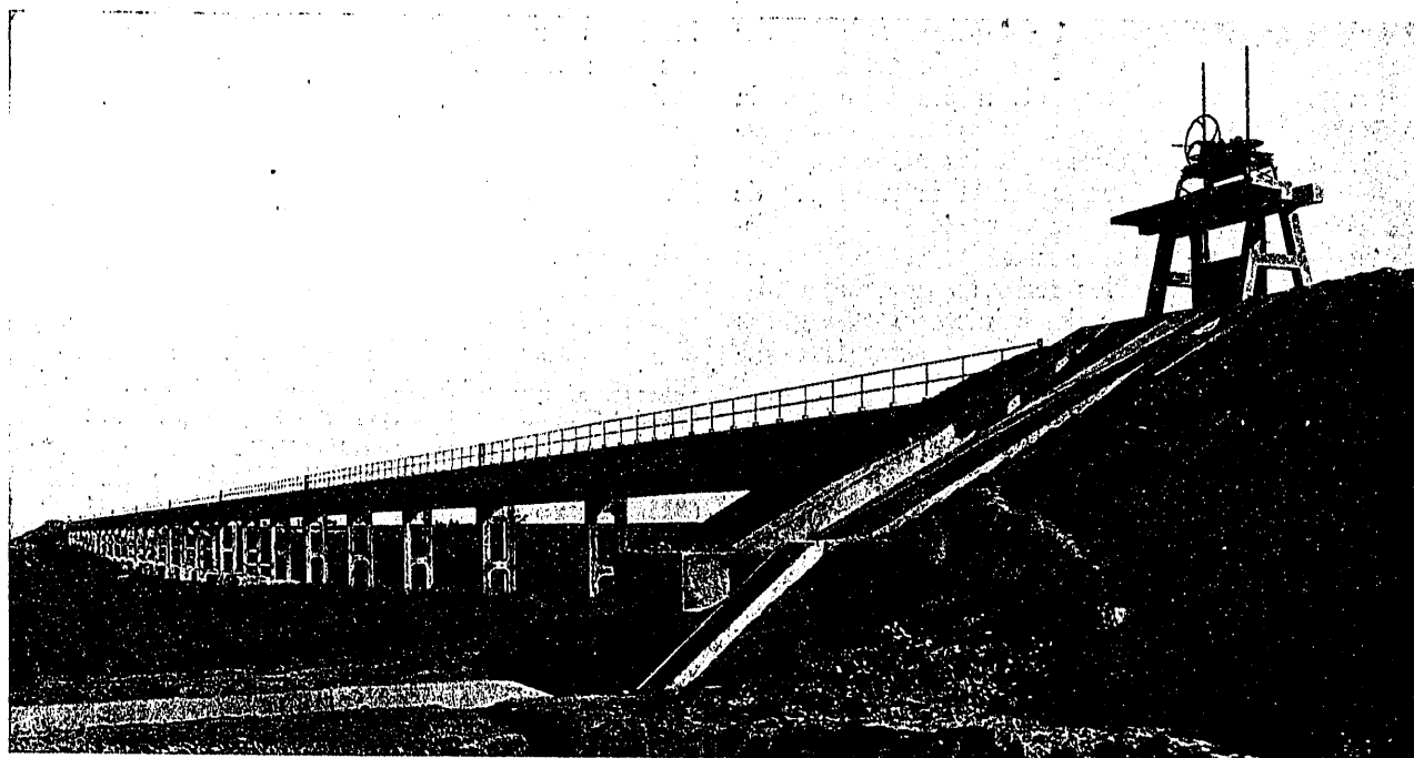
Acueducto sobre el arroyo Miraflores; 27 tramos de 15 m de luz
