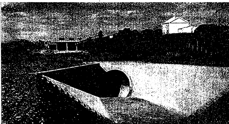
Sifón para el paso del arroyo Garcí-Pérez, de 3 m de diámetro interior y 75 m de longitud
