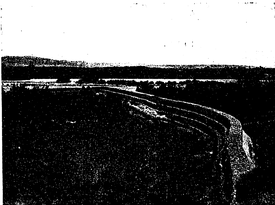
Obras de defensa frente al kilómetro 9 del canal principal en 12 de septiembre de 1923
