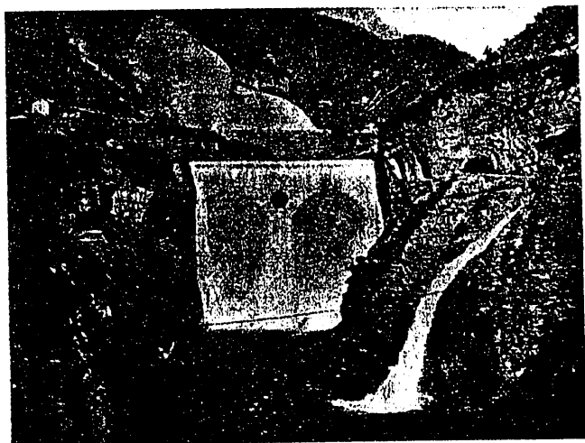
Fig. 8 bis. Presa del Cismon con el vertedero funcionando
