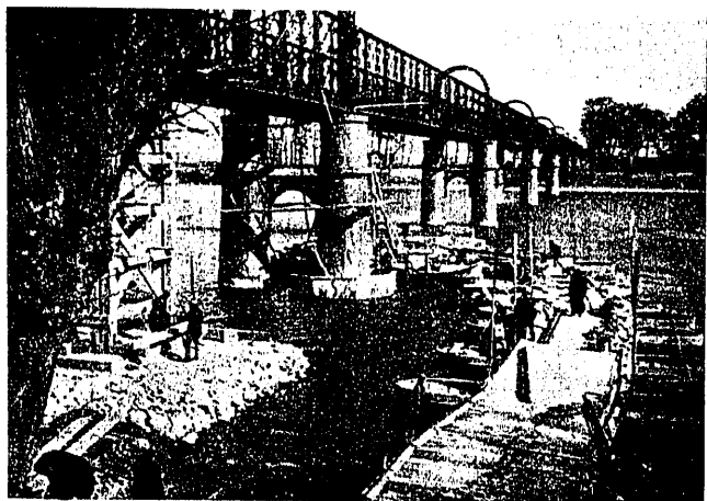
El 20 de febrero queda el cajón sin fondo relleno de hormigón sumergido
