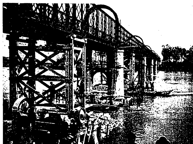
Terminación de la línea de carriles para la atagüa el 5 de marzo
