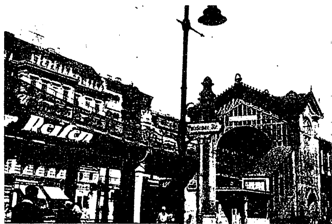
Fot. 1. Estación del ferrocarril elevado, de Berlín
