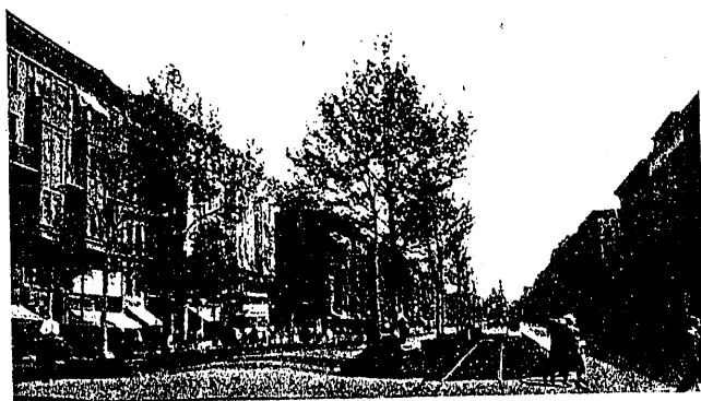
Fot. 6. Berlín. Colocación del tranvía sobre explanación independiente
