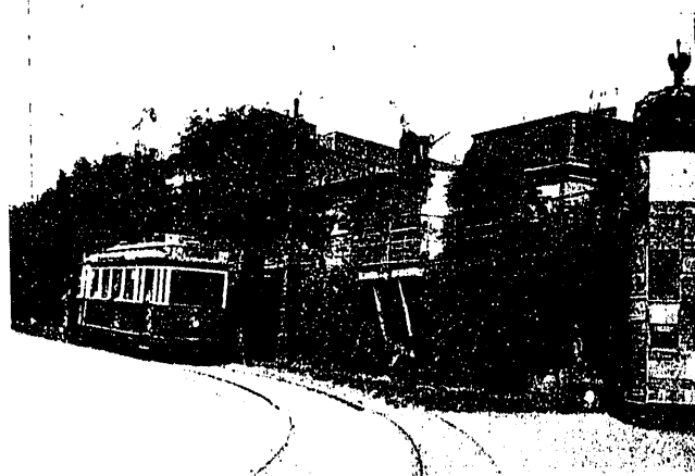
Fot. 8. Vía del tranvía adosada al ferrocarril elevado en la Bülowstrasse, de Berlín
