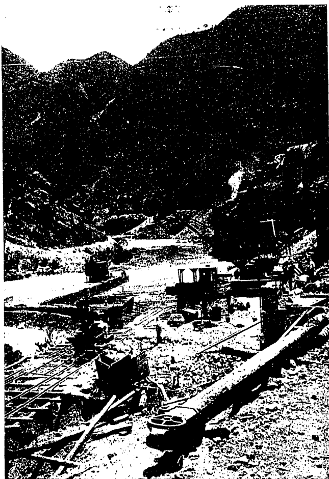
Fot. 21. Recinto y construcción de la ataguía (vista desde aguas arriba)
