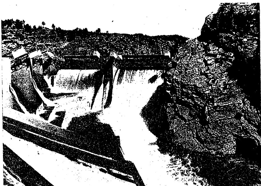
Fot. 3. a Alzas móviles de la presa de Villora y aliviadero del canal
