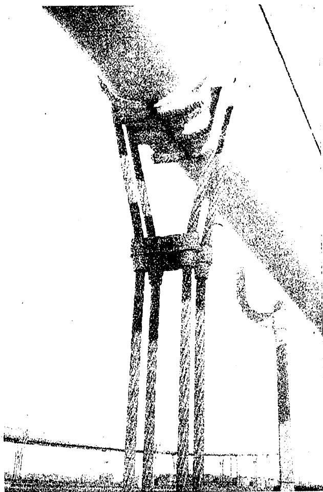
Fig. 6. Unión de una péndola con el cable
