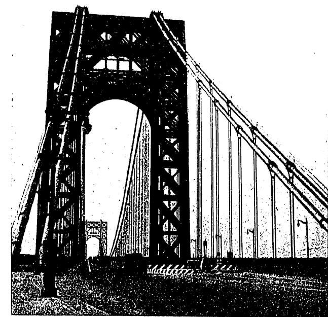
Fig. 2. Torre del lado de Nueva York
