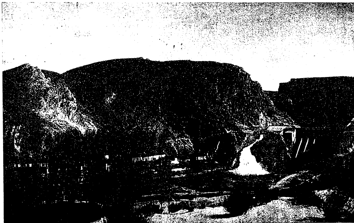
Vista general del aprovechamiento hidroeléctrico del Burguillos
