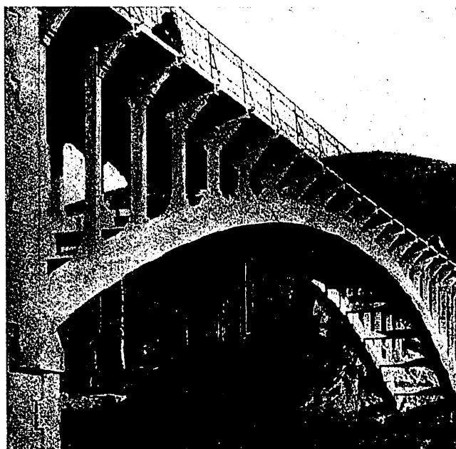
Fig. 3.ª 1900.—Puente de Golbardo, de 30 m de luz. Primer puente en arco de hormigón armado construido en España
