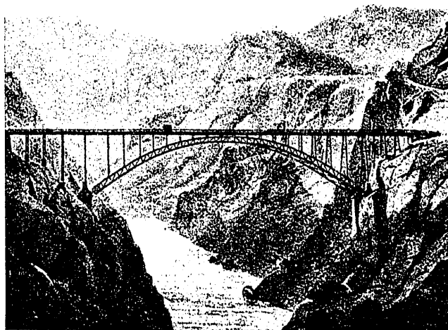
Fig. 2.ª 1895.—Viaducto del Pino, a 90 metros sobre el Duero. Arco articulado de 120 m de luz, el de mayor luz de España
