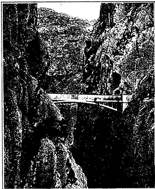
Fig. 9.ª 1907.—Acueducto del Chorro (Málaga). El primer arco de hormigón armado construido sin cimbras, a 100 m de altura.
