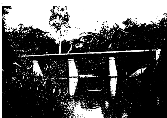
Fig. 15.—Uno de los tramos de 10 a 15 m de luz, que estamos construyendo en Guinea.
