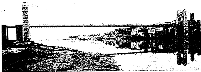
Fig. 11. 1909.—Puente sobre el Ebro, en Amposta (Tarragona). Adjudicado en concurso de proyectos de 135 m de luz, la mayor de España. El estribo izquierdo se cimentó con un cajón neumático a 29,50 m de profundidad, que creo es la mayor alcanzada con aire comprimido
