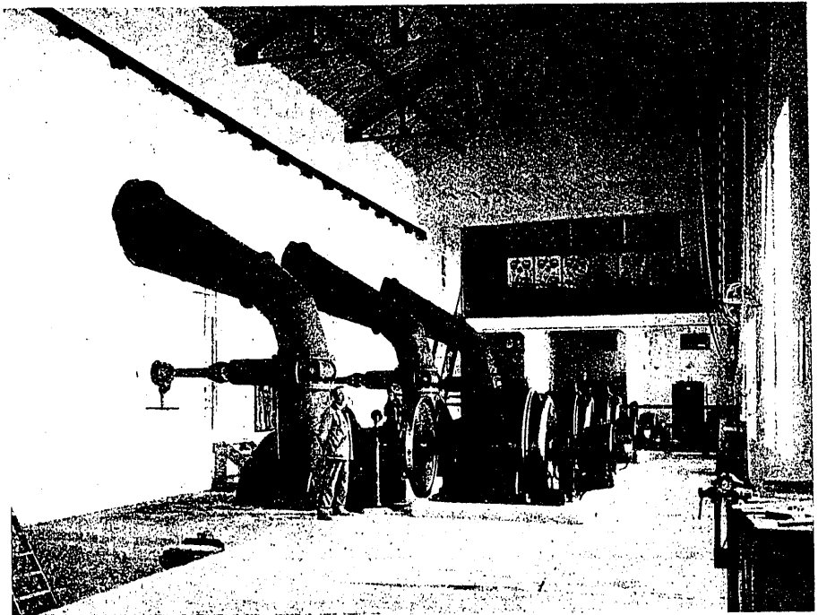
Fot. 5.ª Interior de la Sala de máquinas.
