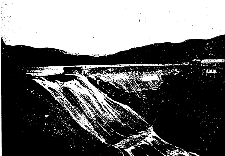
Fig. 1.ª Vista de la presa de embalse y aliviadero de superficie
