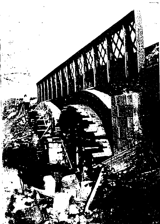
Puente Sarria 3.º—"Construcción del nuevo puente debajo del tramo metálico"
