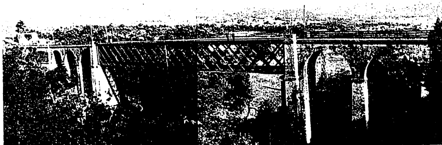
Viaducto Liñares.—"El tramo metálico antes de empezar la sustitución"
