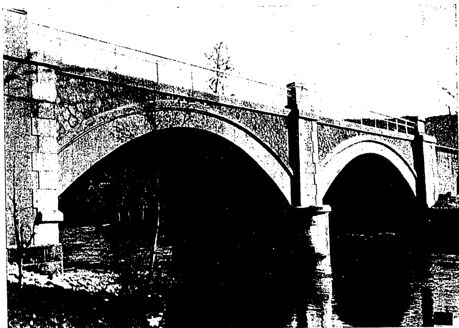
Puente Sarria 3.º.—"El puente nuevo, terminado"
