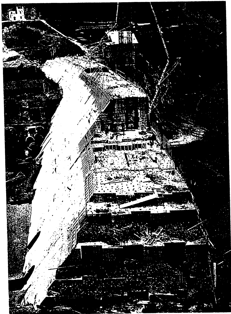
Fig. 9. a Una fase de la construcción
