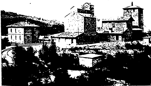
Fig. 11. Fábrica de cemento del Consorcio
