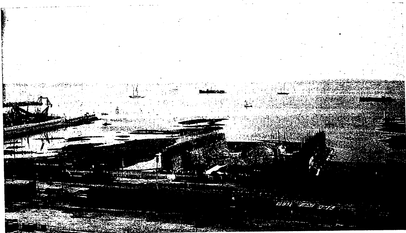
Fig. 12. Vista del cajón cuádruple desde las murallas de Cádiz. Por el lado del mar se ve la borda de madera que como botaolas le defiende de la marejada del Norte. Entre las zonas que descubre la baja mar se ve el cuenco dragado, y a la izquierda, fondeado a la entrada de la dársena, el cajón de la Casa de Bombas.
