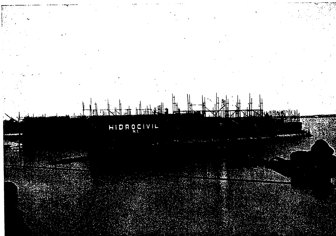
Fig. 8.* Bloque monolítico de los cuatro primeros cajones, con 16 000 toneladas de desplazamiento en el momento de la fotografía, fondeado sobre su emplazamiento definitivo en el cuenco dragado para el Dique Seco
