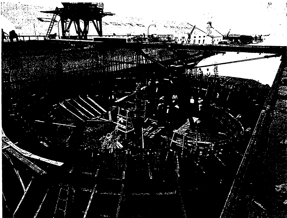
Fig. 6.ª Hormigonado de la Casa de Bombas. En el centro, la columna de apoyo del puente-grúa de servicio de la instalación de agotamiento
