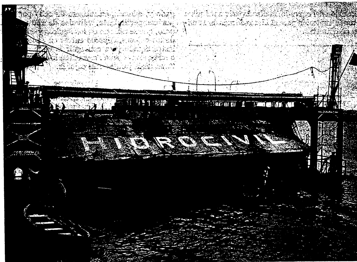
Fig. 21. El cajón terminado y próximo a botarse
