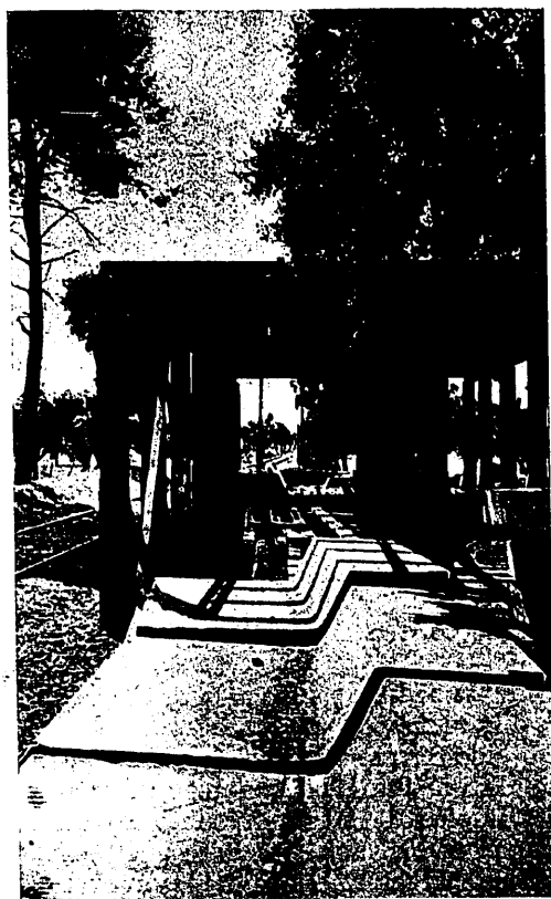
Fig. 5.ª Parque para construcción de losas (frente)
